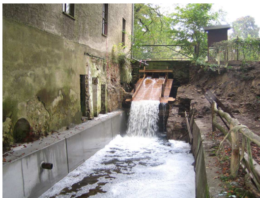
Bild: Sanierte Grundmauer der Mühle, November 2007
